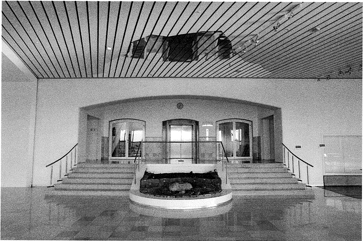
Ausstellungshalle. Blick nach Osten auf die Treppenanlage.
