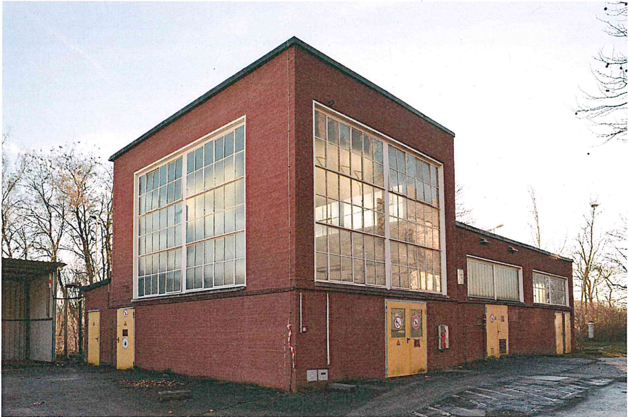
Acetylen-Erzeugung. Ansicht von Nordosten.
