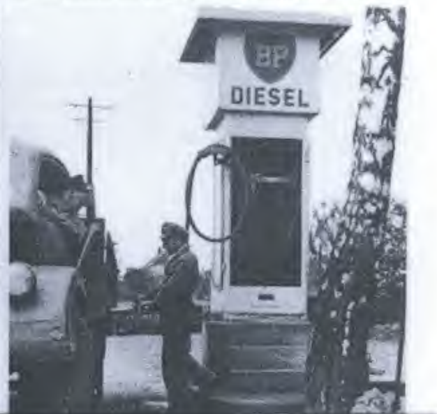
Dieselpapfsöhle mit eingebauter Hochwaage, um 1938
