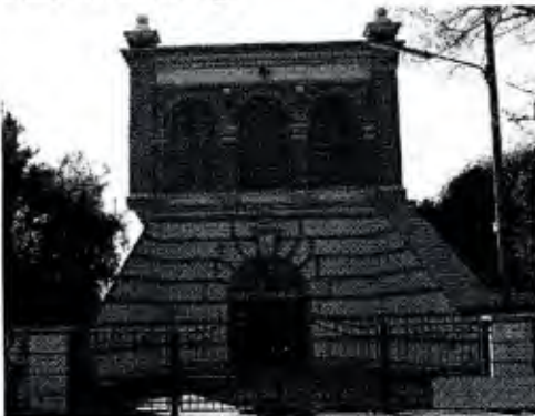
Hauptfassade und Flügelmauern
