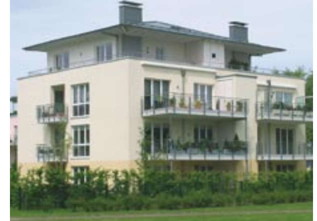
„Wohnen auf der Stadtkrone-Ost“, Dortmund Hochwertige frei finanzierte Eigentumswohnungen und Eigenheime in parkähnlicher Landschaft
