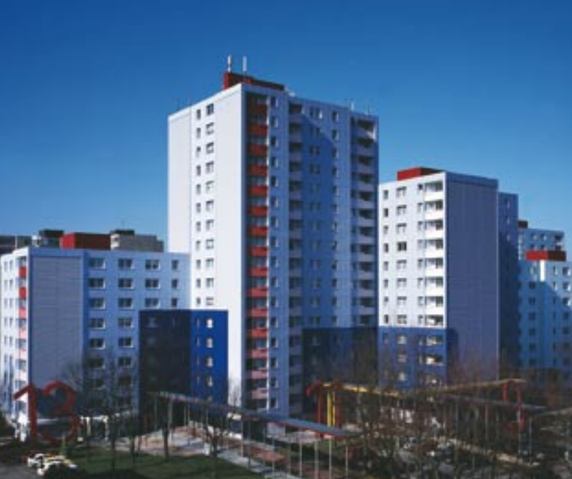
Der Clarenberg in Dortmund-Hörde: Positivbeispiel für den nachhaltigen Umgang mit einer Großwohnsiedlung. Ein ganzes Bündel an Maßnahmen hat den einst schwierigen Wohnstandort für seine Bewohner/innen wieder lebenswert gemacht.
