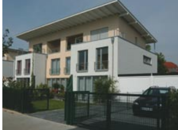
Ruhrpark, Bochum-Dahlhausen: Attraktives Wohngebiet mit Eigenheimen und Eigentumswohnungen an der Ruhraue zwischen dem Eisenbahnmuseum und dem Stadtteilzentrum Dahlhausen
