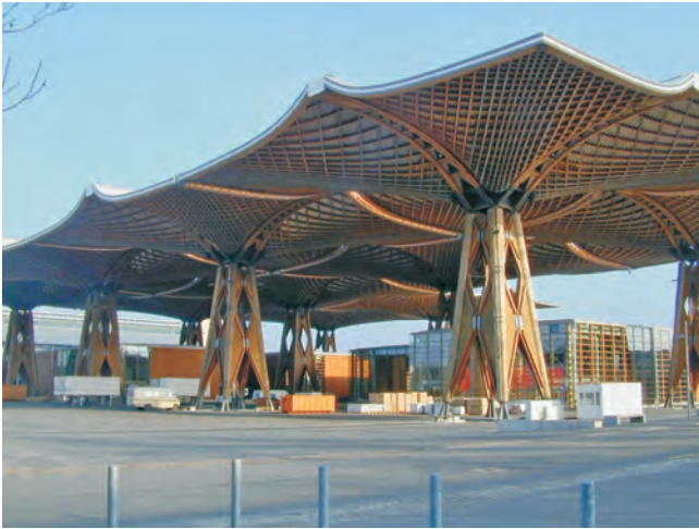
Das größte selbsttragende Holzdach der Welt steht auf der Messe in Hannover und wurde zur EXPO 2000 gebaut. 1
