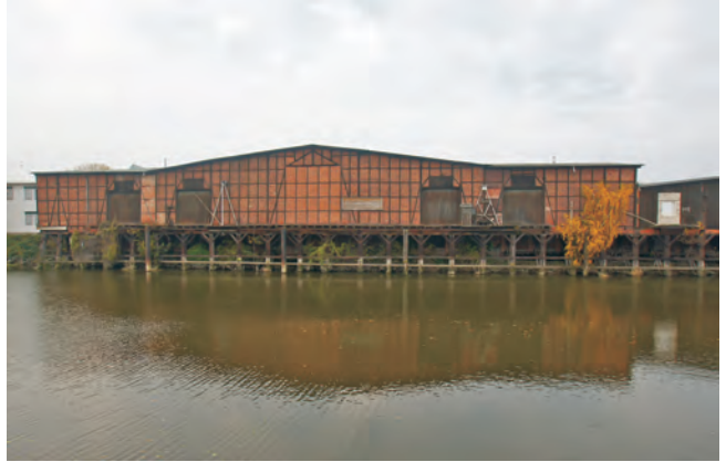
Fachwerkspeicher am Marktkanal in Veddel 8
