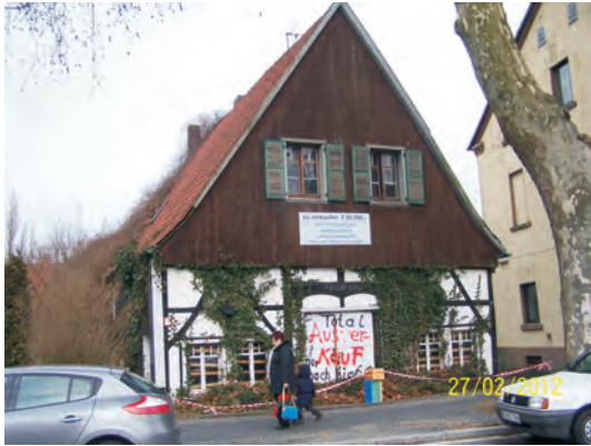
Unterstraße 12 (Bauzustand Februar 2012)
