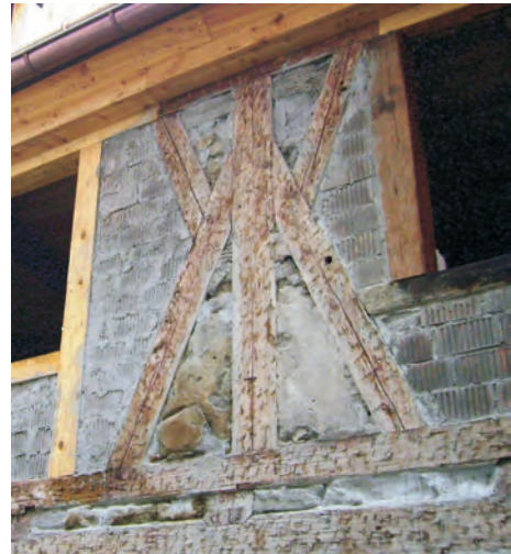
„Wilder Mann“ an Sanierungsobjekt in Lauf/Pegnitz 4
