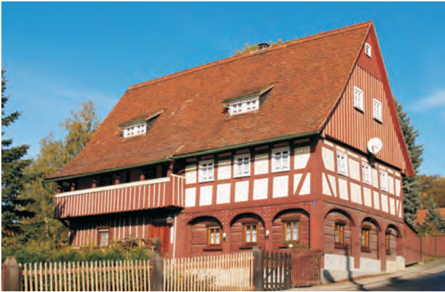
Umgebäudehaus in Ebersbach/Sa. 12 9
