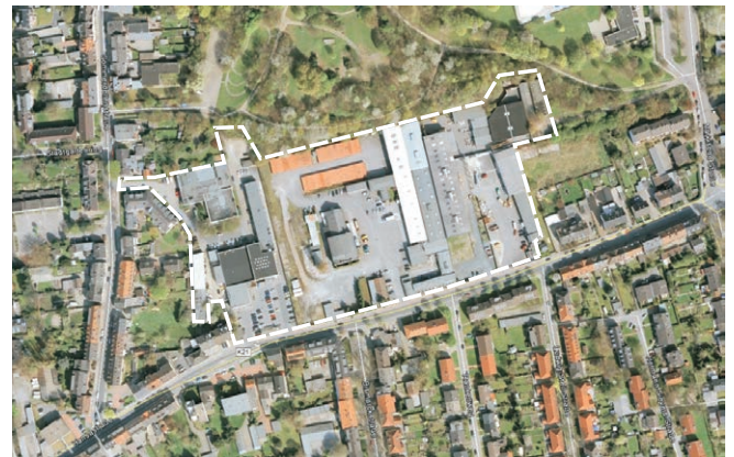
Gewerbe nördlich der Hansastrasse
