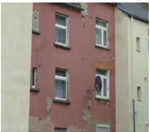
Schwere Schäden an der Außenhaut, wie z. B. abfallender Putz aufgrund von Feuchtigkeitsschäden, marode Fenster, konstruktive Mauerwerksrisse, unzureichende Dacheindeckungen, ggf. einsturzgefährdet
